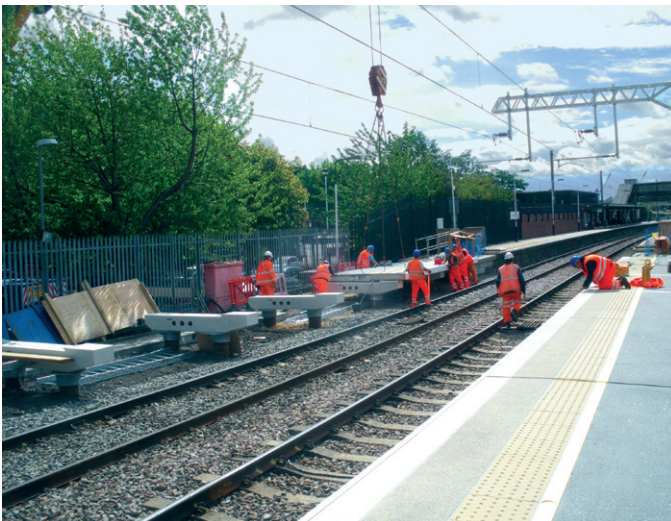
Abb. 1: Tiefgründung eines modularen Bahnsteigs mit Stahlrampfpfählen und Vollfertigteil-Kopfbalken bei der Errichtung von Bahnsteigen in Bedford (UK)
