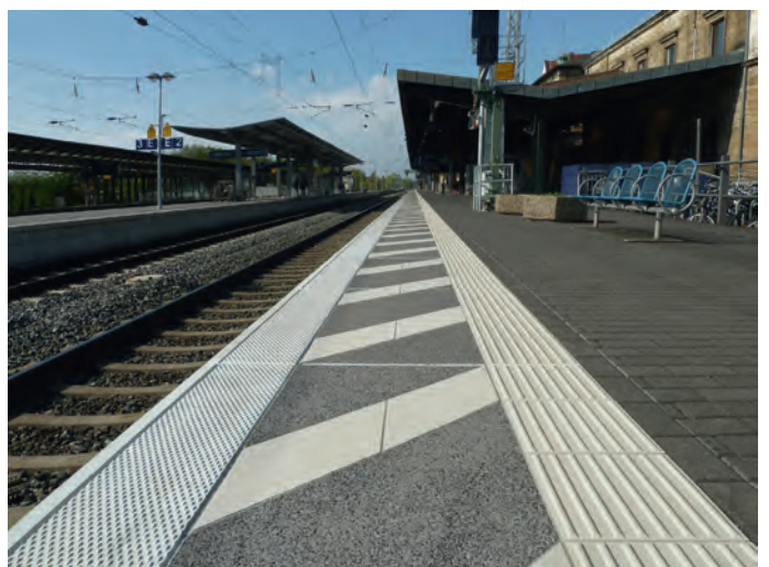
Abb. 3: Bahnsteig in Erlangen nach der Sanierung: Durch den Einsatz von modula flex als Ergänzungsplatte konnte der Abstand der konventionellen Bahnsteigkante zur neuen Gleisgradienten angepasst werden.
