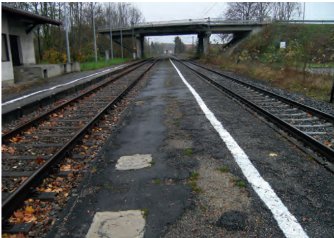
Abb. 2: Vorher, nachher: In Walleshausen wurde an einem Bahnsteig die marode Bahnsteig-Oberfläche – während der normalen Betriebsruhezzeiten bzw. Zugpausen und ohne Beeinträchtigung der Reisenden – saniert.
