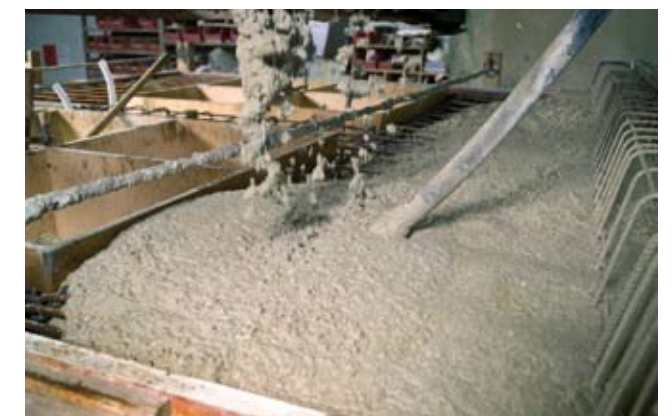
Herstellung von stahlbewehrten Fassadenelementen
