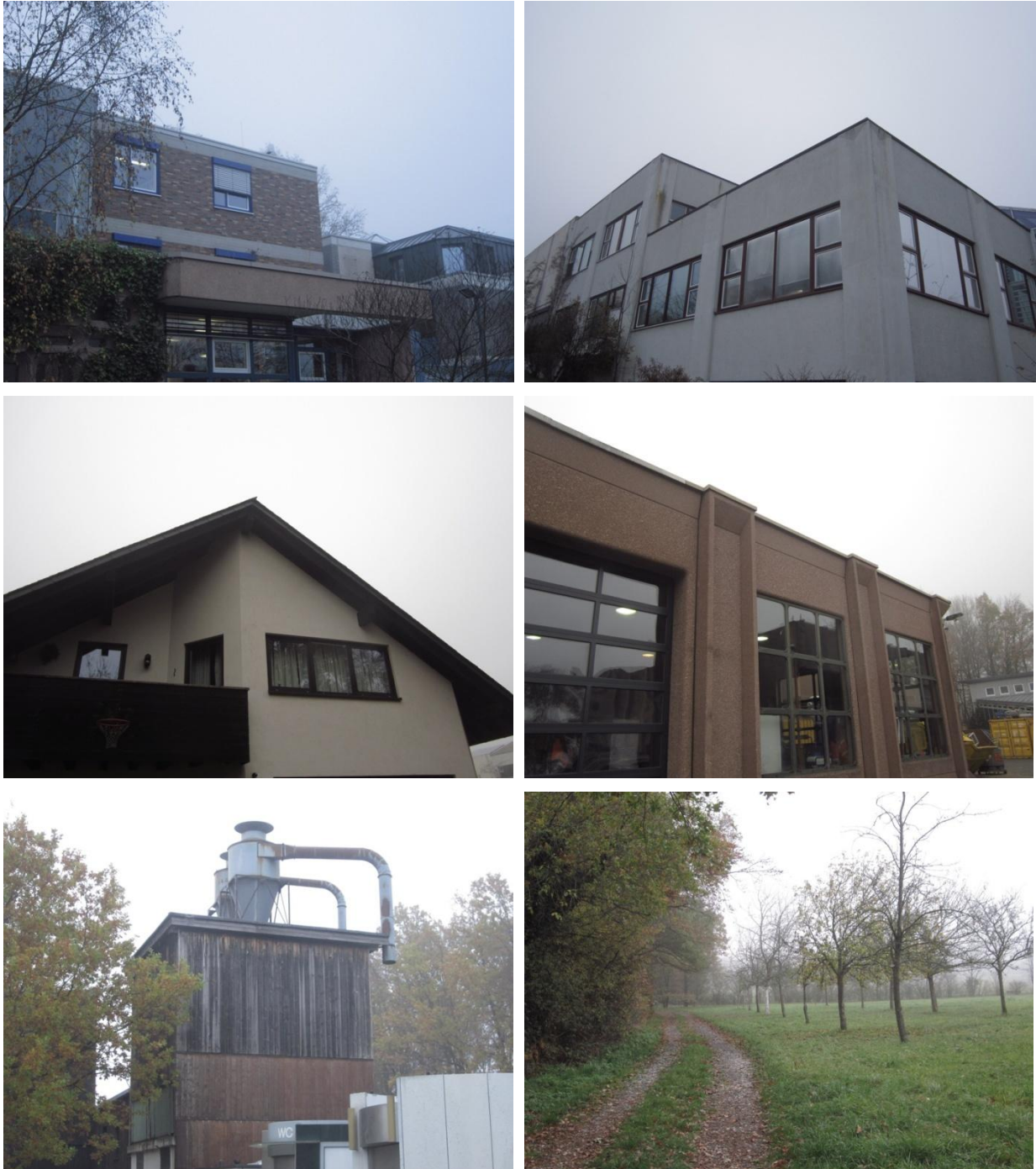
Abb. 13: Für die Installation von künstlichen Mehlschwalbennestern und Mauerseglerkästen bietet sich die Ostfassade des Verwaltungsgebäudes an (oben links). Nach Osten und Süden exponierte Fassaden eignen sich besonders gut zur Installation von Fledermausbrettern oder die Anbringung von Turmfalkenkästen (oben rechts). Die östliche Giebelfassade des Gebäudes Hoorwaldstraße 77 ist sehr gut geeignet für die Konstruktion eines Giebel-Spaltenquartiers für Fledermäuse (mitte links). Zwischen die Trennelemente der Betonfassade an zwei KFZ-Hallen im Norden des UG können einfache Fledermausbretter die Quartiersituation für spaltenbewohnende Fledermausarten verbessern (mitte rechts). An der nach Süden und Osten exponierten Holzfassade des ehemaligen Sägemehlbunkers können direkt unter den Trauf große Fledermausbretter, alternativ auch eine doppelte Verschalung mit Einschlupf für Fledermäuse konstruiert werden (unten links). Der südlich gelegene Baumbestand sowie die angrenzende Obstwiese eignen sich besonders gut für die Einrichtung eines Fledermauskasten-Revieres (unten rechts). (Fotos: M. Graf)
