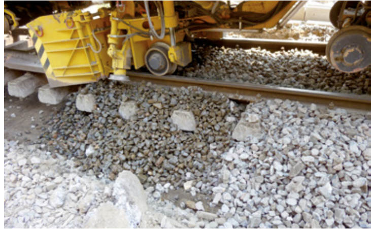
Einbau des gewaschenen und gereinigten Schotters ins Gleis
