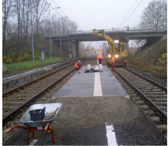
Montage der ersten modula®flex-Bahnsteigplatten im Pilotprojekt Walleshausen.
