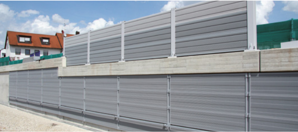
Neubau einer Schallschutzwand in Erlangen-Bruck auf einem Teilstück der ICE-Strecke zwischen Nürnberg und Leipzig mit Zuggeschwindigkeiten bis zu 200 km/h.
