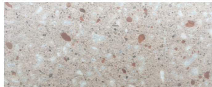
Fassadenoberfläche Rathaus Korbach (HERING Bau)
