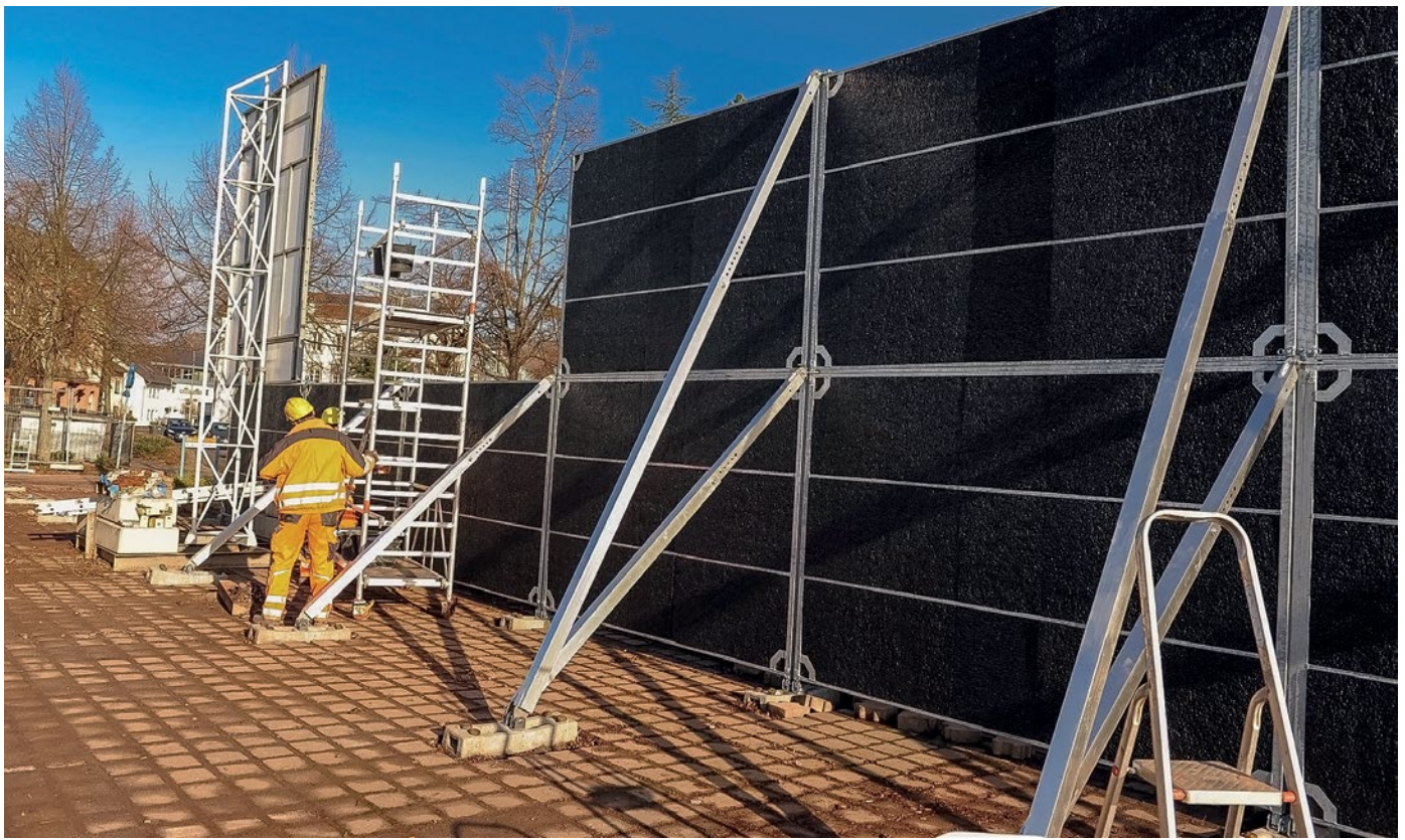
Abb. 4: Die temporäre Lärmschutzwand lässt sich durch das modulare Konzept und das geringe Gewicht schnell und einfach montieren.
