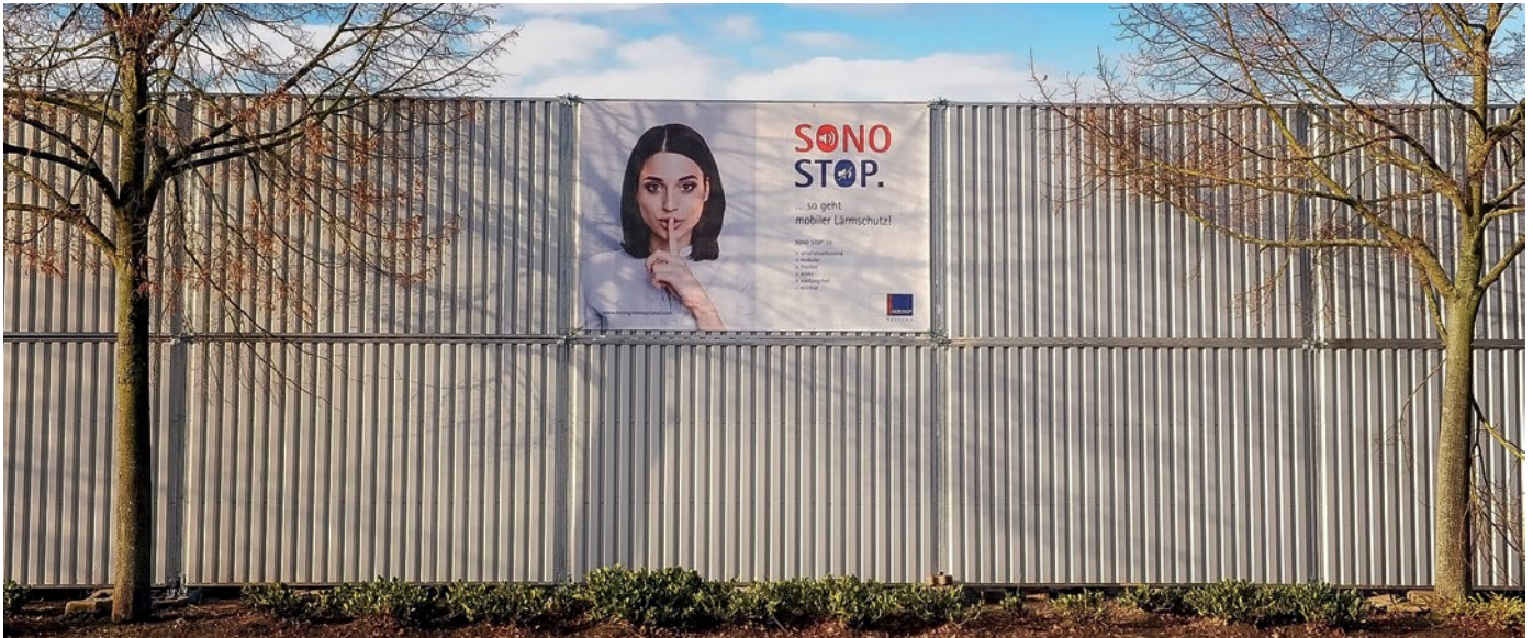
Abb. 1: Erfolgreiches Pilotprojekt mit temporärer Lärmschutzwand in Merzig
