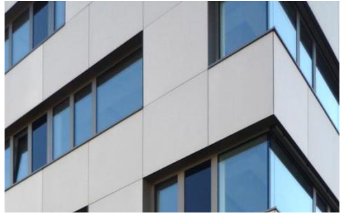
Bild 3 Kleinformatige Fassadenplatte des Alfred-Hütter-Labors in Dresden; Entwickelt in Zusammenarbeit der TU Dresden und Hering Bau Small-sized TRC façade of the Alfred-Hütter laboratory hall in Dresden; developed by the cooperation between Hering Bau and TU Dresden
