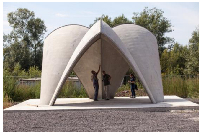
Bild 2 Filigrane Schale: Pavillon Kahla; entwickelt an der TU Dresden [3] Filigree TRC shell: pavilion Kahla; developed at TU Dresden
