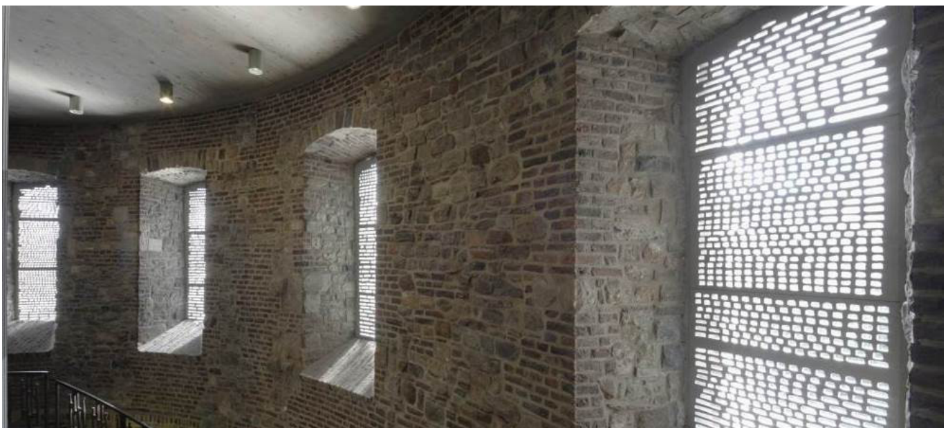
Bild 10 Ansicht der rekonstruierten Fenster aus dem Innenraum des Marienturms View from the inside of the Marientower of the reconstructed historical windows
