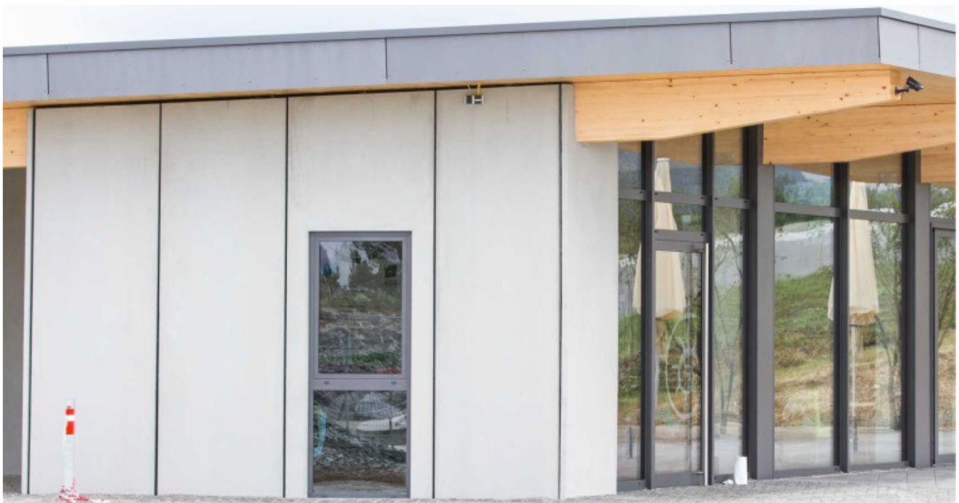
Bild 6 Ansicht der Fassadenplatte „SchieferErlebnis“ in Dormettingen (Foto: Solidian) View of the façade of „SchieferErlebnis“ in Dormettingen
