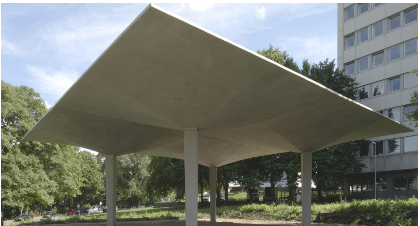
Bild 12 Ansicht des Pavillons nach Abschluss der Rohbauarbeiten View of the pavilion
