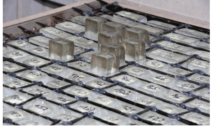
Bild 9 Ansicht der Carbonbewehrung vor der Betonage View of the carbon reinforcement before concreting
