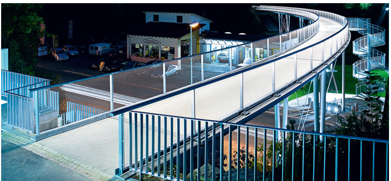
Bild 14: Ansicht der Textilbetonfußgängerbrücke in Albstadt (Foto: Solidian) View of the Textile-Reinforced bridge in Albstadt
