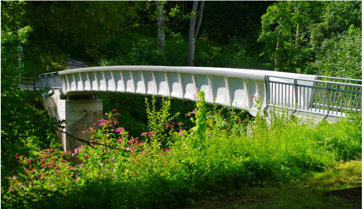
Bild 15 17 m lange Segmentbrücke in Kempten mit integriertem Geländer und 30 mm starken Schalen aus Textilbeton [19], [20] 17 m span bridge in Kempten with integrated railing and 30 mm thick TRC shells
