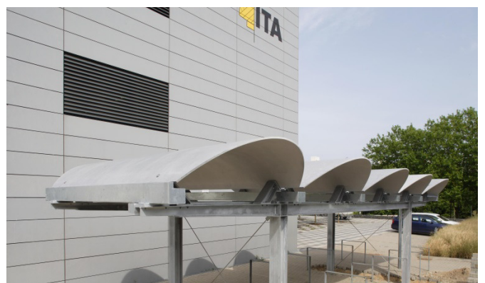
Bild 17 Filigrane einfach gekrümmte Schale aus Textilbeton [18] Filigree single-curved TRC shell
