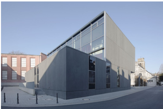
Bild 1 Großformatige Fassadenplatten aus Textilbeton an der Fassade der Mensa des St. Leonhard Gymnasiums in Aachen [2] (Foto: Robert Mehl) Large-sized façade TRC elements of the cafeteria façade of the St. Leonhard school in Aachen
