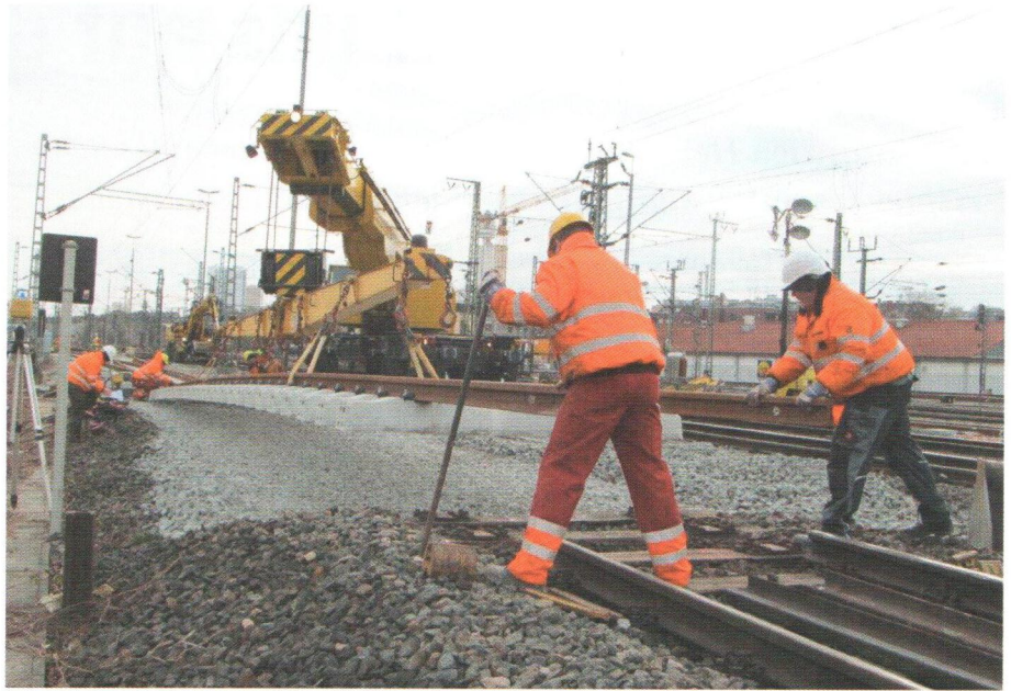
Abb. 3: Montage einer Weiche im Bahnhof Frankfurt/M. (Süd)
