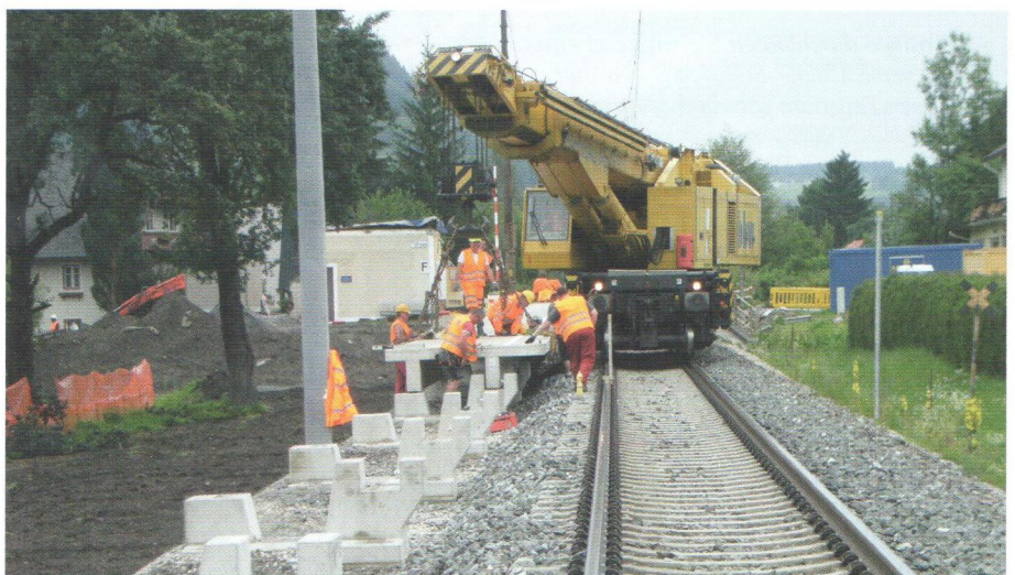
Abb. 2: Montage eines Bahnsteiges aus Betonfertigteilen
