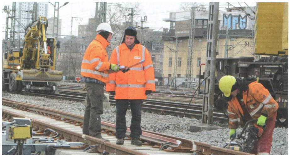
Abb. 1: Bahnbauingenieure im Einsatz vor Ort
