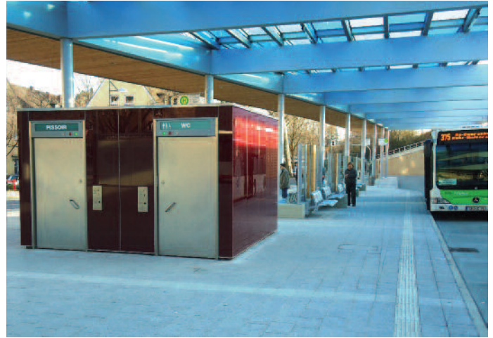
Eine City-WC-Anlage mit Glasfassade aus dem Hause Hering steht am ZOB Witten.
