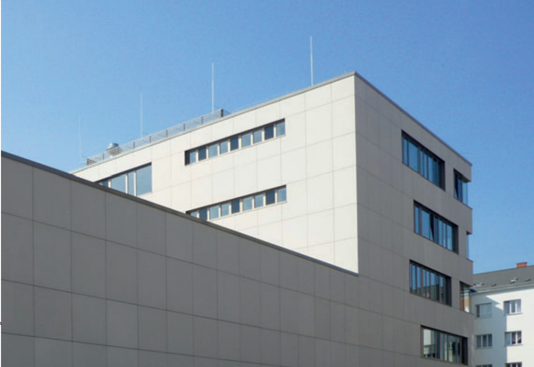
Für den fünfgeschossigen Kopfbau des Laborgebäudes der TU Dresden, entschieden sich die Architekten vom Büro Schubert und Horst für den Einsatz innovativer betoShell-Textilbetonelemente. Diese zeichnen sich durch ihre weiße gesäuerte Oberfläche aus.
