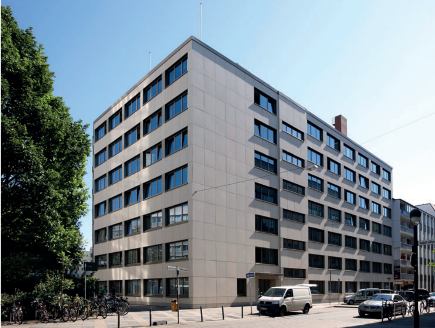
betoshell-Elemente eignen sich aufgrund Ihrer geringen Stärke und des geringen Gewichts besonders gut für energetische Fassadensanierungen, wie hier beim Projekt Performa Nord in Bremen
