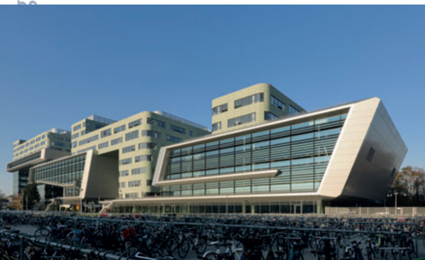
Über 10.000 grün eingefärbte betoShell BIG – Fassadenelemente mit gesäuerter Oberfläche wurden für den Neubau des ROC Leiden von Hering hergestellt und montiert
