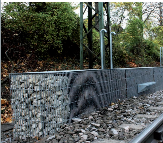
Bonn-Bad Godesberg, 53 cm über Schienoberkante, 536 m lang, mit Gitterrostabdeckung und Übersteighilfen. (Quelle: Hering)
