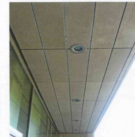
Bei den Deckenelementen handelt es sich um eine andere Betonrezeptur, farblich konnte die Oberfläche aber der Fassade angeglichen werden.
