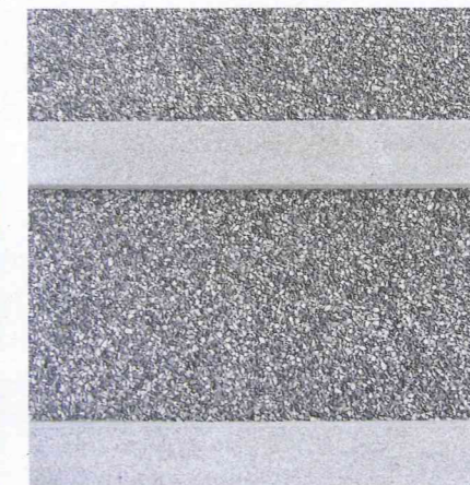
Die Sichtbetonfassade wurde mit Pigmenten eingefärbt. Mit Säurebehandlung erhielt sie Horizontalstreifen.
