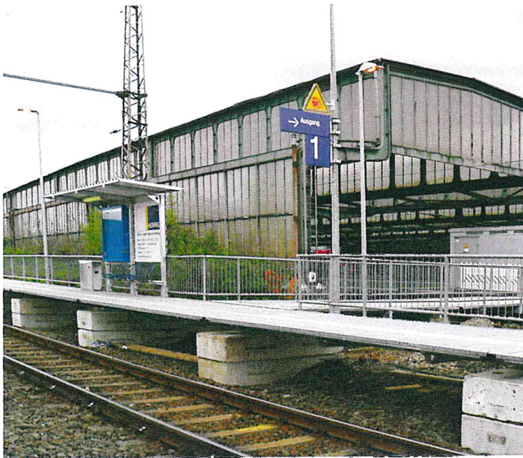
Behelfsbahnsteig in Duisburg auf 55 cm Niveau, gestapelt auf Standard-Fertigteilfundamente (li.), Darstellung Systemschnitts (re.)
