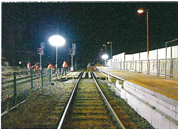
Bahnsteigbrücke aus temporären Bahnsteigelementen Typ modula® in Meckenheim, während (o.) und nach (u.) der Montage
