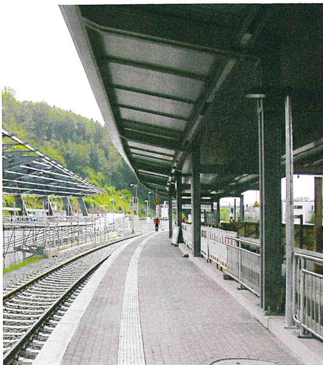
Aufgrund der extremen Bogenlage wurde der Dachrand des rund 90 m langen Bahnsteigdachs Bodenheim light, am neuen Bahnhof Gummersbach, polygonal ausgeführt.
