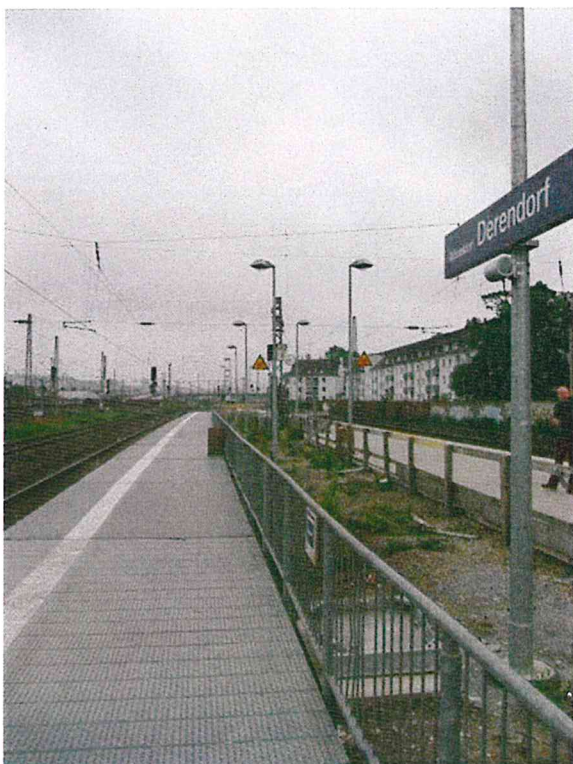
Behelfsbahnsteig modula®temporär in Düsseldorf-Derendorf
