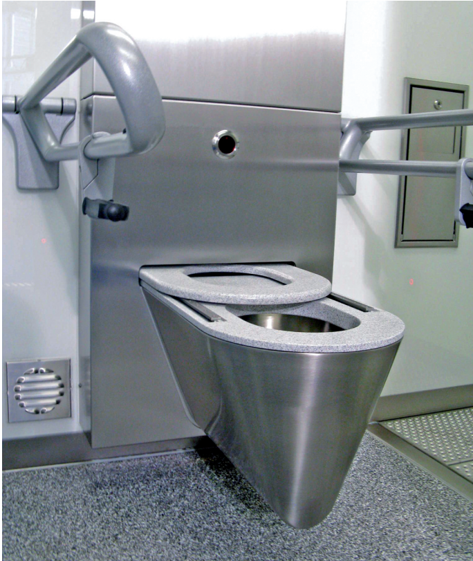
Wie von Geisterhand zieht sich die Toilettenbrille in den Technikraum zurück, wird dort gereinigt und desinfiziert – und wieder nach vorne geschoben.
