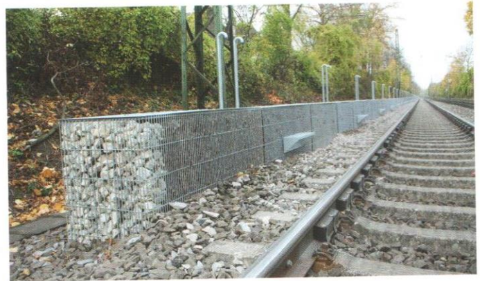
BILD 5: Kombination einer niedrigen Schallschutzwand Typ Gabione mit Schienenstegdämpfern
