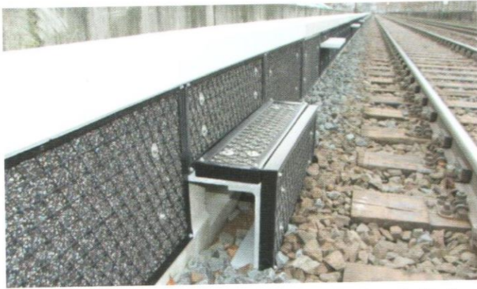
BILD 4: System ZBloc: niedrige Schallschutzwand in Betonfertigteilbauweise mit vorgehängenen Absorbermatten
