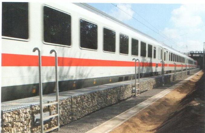
BILD 1: Niedrige Bauhöhe und hohe Effektivität: niedrige Schallschutzwand, Typ Gabione in Andernach
