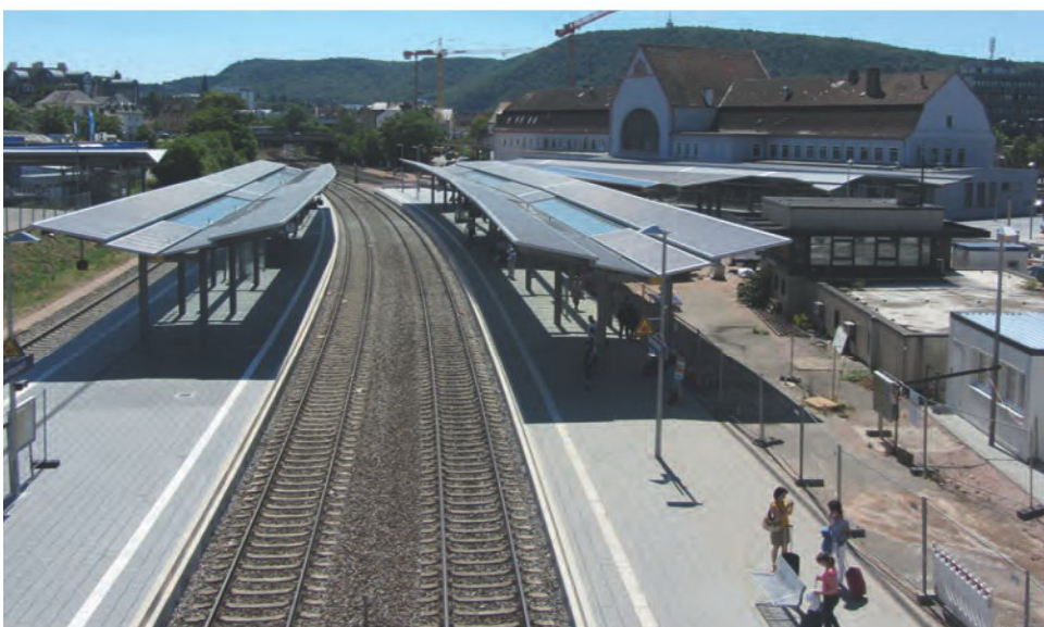
Abb. 1: Nach den Baustandards der DB Station & Service AG sollen künftig Verkehrsstationen in Deutschland in BIM geplant werden.
